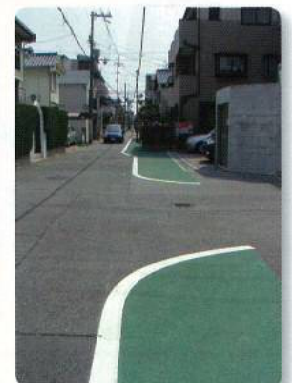
グリーンベルトの設置
