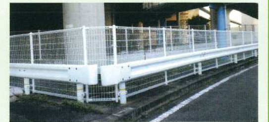
▲水路転落防護柵 (猪名川大橋下)
