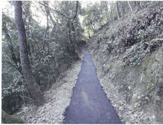
① 舗装されたコミュニティ道路
