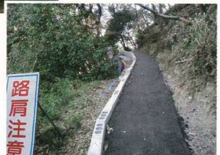
舗装工事完了部分
