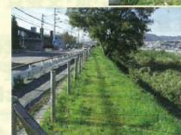
① 河川堤防敷
