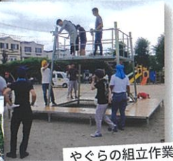
やぐらの組立作業
