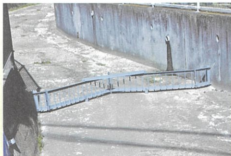
①今井水路改修工事
