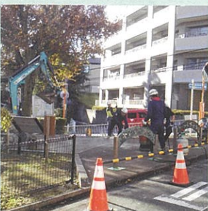
路面舗装工事
