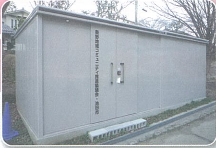
渋谷公園防災倉庫設置
