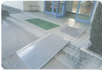
秦野小学校体育館スロープ設置
