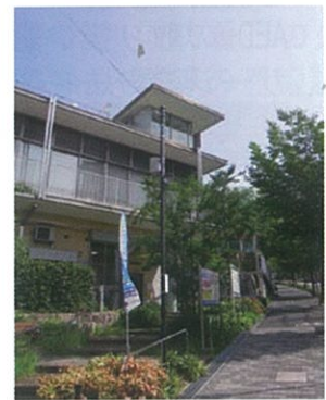
防犯カメラ設置
