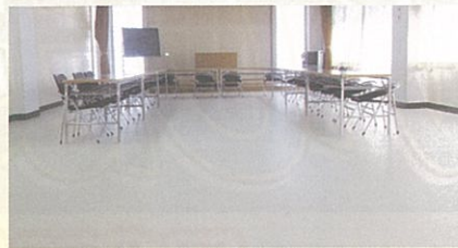
老朽化した床が綺麗になった 9月実施
