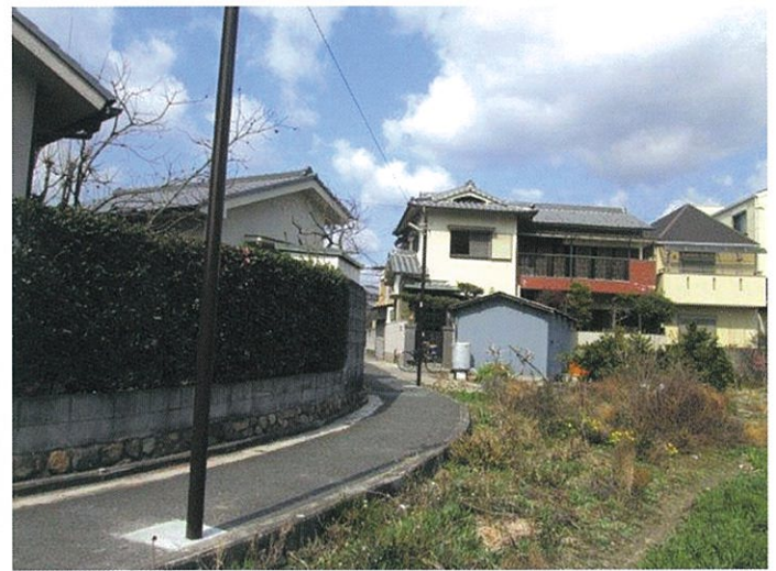
街路灯新設 (神田4丁目)
