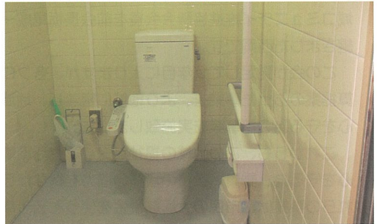
1Fトイレ和式から洋式に改修
