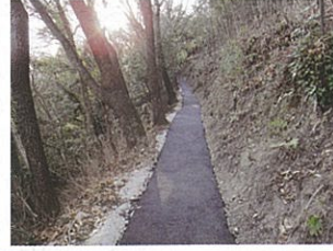
舗装工事完成
