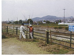
余野川堤防桜植栽
