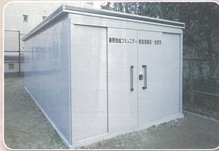
7月 南畑公園防災倉庫設置
