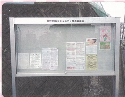
掲示板10か所の改修
