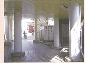
橋脚補修事業
